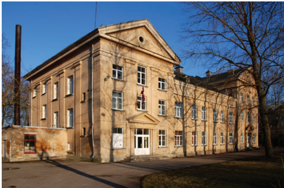
44. att. Lauksaimniecības biedrības „Druva” nams Bērzē. 1923. Arhitekts A. Vanags. Mūsdienu fotofiksācija
