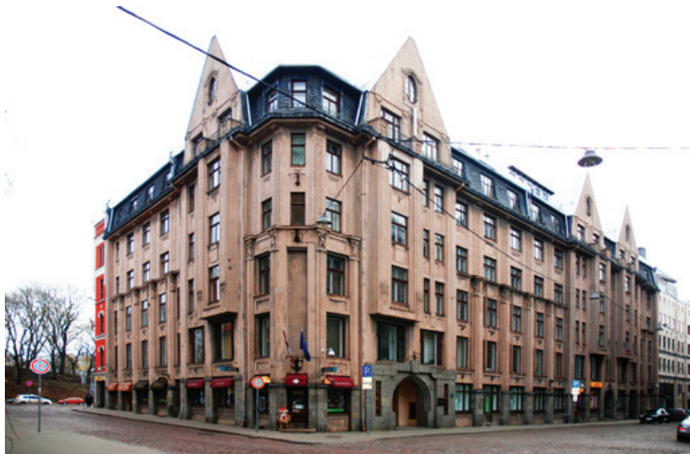
32. att. Vidzemes Guberņas lauksaimnieku savstarpējās palīdzības biedrības nams Vaiņu ielā 2, Rīgā. Arhitekts E. V. E. Frizendorfs, 1911. Fotofiksācija mūsdienās
