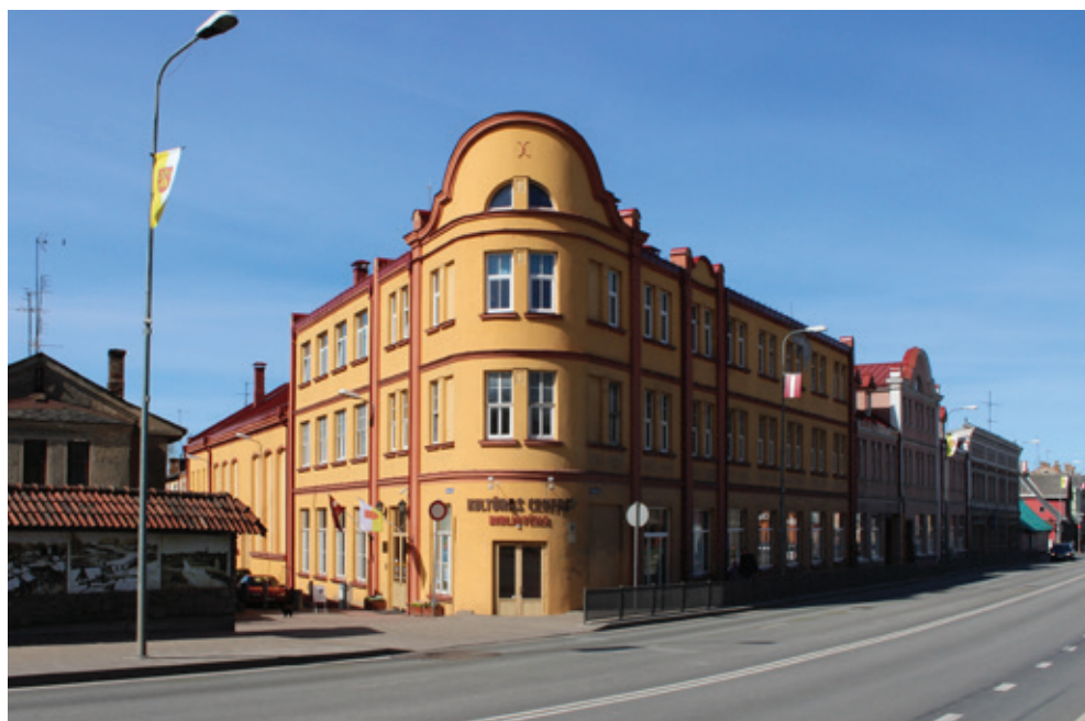
33. att. Bauskas Muižniecības nams. Kalna ielā 18. 1911. Fotofiksācija mūsdienās
