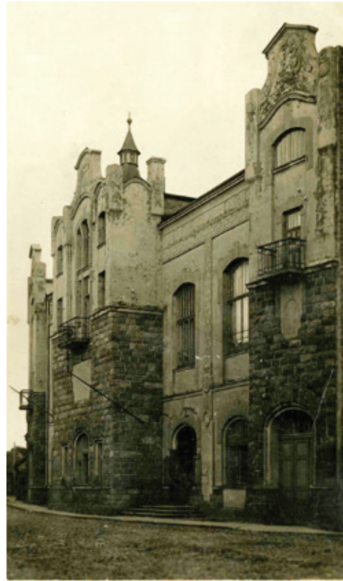
7. att. Ventspils Latviešu biedrības nams Maiznieku ielā 11. Ap 1910. g. Arhitekts, iespējams, E. Bauls. Atjaunošana un pārbūve — 2009, arhitektu birojs “Virtu”. 20. gs. sākuma pastkarte. [Arhitekta J. Lejnieka personīgā arhīva materiāls]
